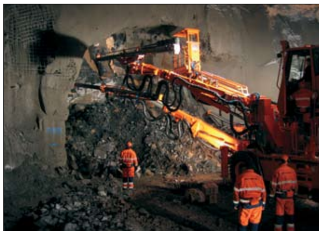
Héðinsfjarðargöng. Gangagerð í Ólafsfirði. Myndir: Björn A. Harðarson, GeoTek ehf. Einnig mynd á forsíðu.
